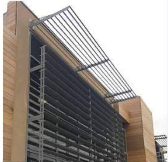
Lames brise-soleil surmontées d'une « protection casquette » au niveau le plus élevé
